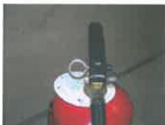
4) Sacar la anilla de seguridad para poder accionar el mecanismo de disparo. Disponen de un precinto de seguridad que se elimina de un simple tirón.
